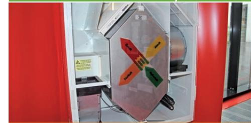
Lüftungsanlagen mit Wärmetauscher (= Wärmerückgewinnung) nutzen die Wärme der verbrauchten Luft zur Vorwärmung der Zuluft.
