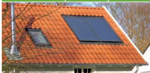
Größere solarthermische Anlagen können nicht nur zur Erwärmung des Brauchwassers genutzt werden, sondern auch zur Vorwärmung des Heizungswassers.
